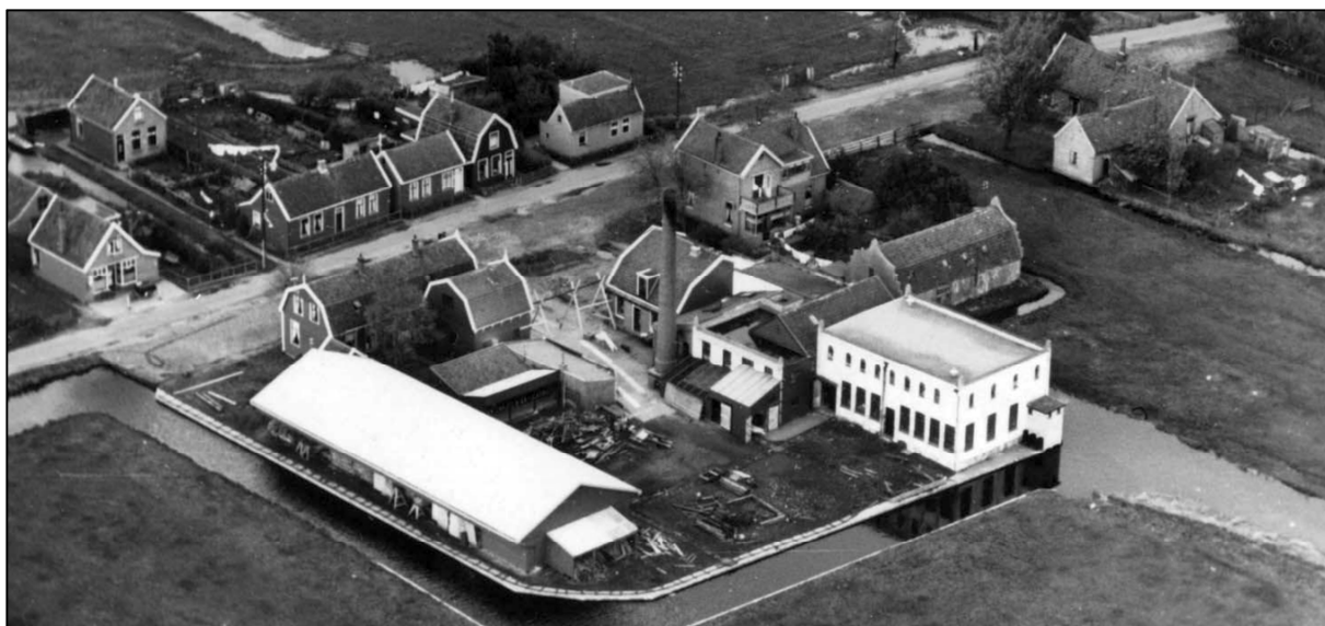
Luchtfoto van het bedrijf in de jaren omstreeks 1950-1960. Rechts, op het meest oostelijke stuk van het perceel, was eind 19 e eeuw de eerste fabriek verrezen, in 1912 verbouwd en uitgebreid tot het twee verdiepingen tellende witte stenen gebouw. De schoorsteen dateert uit 1928 met in het verlengde daarvan een in 1909 gebouwd kantoor, inpakafdeling en bergplaats. De stenen schuur noordelijk daarvan (achter J.J. Allanstraat 184) verrees in 1906 en 1908, gebouwd door timmerman J. Buis en werd later ook door de fabriek opgekocht. De loods op de voorgrond dateert uit 1946 en zou in 1966 worden vervangen door een nieuwe showroom. De fabriek uit 1909 is in 1966 vervangen door een romneyloods. Voor aan de weg het dubbele woonhuis uit 1911. Duidelijk zichtbaar is ook de smalspoorrails aan de rand van het terrein. © Collectie Gemeentearchief Zaanstad, 41.01195.
