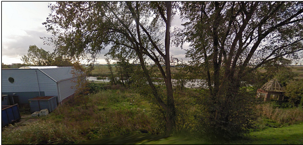
Rechts de restanten van een tuinthuisje bij Overtoom 79 en links het bedrijfspand van Crock Transport. In het midden zijn funderingspalen voor een nieuw huis te zien. Foto © GoogleMaps/Streetview.
