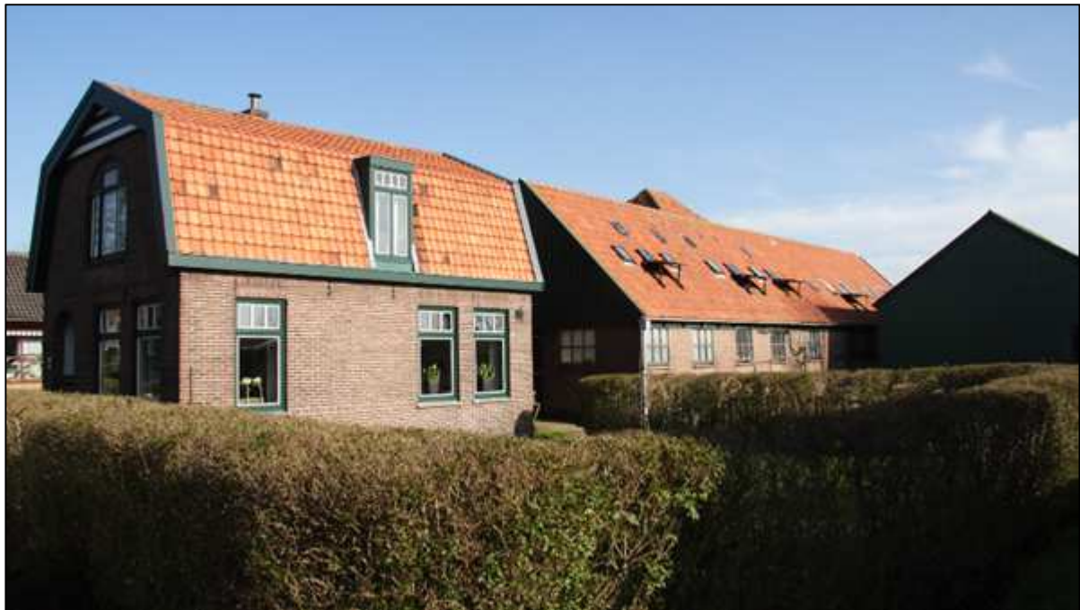
Een foto van de boerderij J.J. Allanstraat 350 uit 2014 die twee jaar later reeds geschiedenis is; de stalling en hooiberg uit 1913, achter het woonhuis uit 1926, zijn in 2016 gesloopt. De schuur rechts op de foto is vervangen door een houten schuur.
