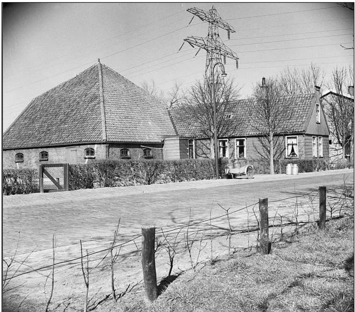
De boerderij J.J. Allanstraat 101 in 1958. Rechts is J.J. Allanstraat 103 zichtbaar. De hoogspanningskabels ter hoogte van J.J. Allanstraat 119-125 zijn reeds aanwezig. Foto © Collectie Rijksdienst voor Cultureel Erfgoed.
