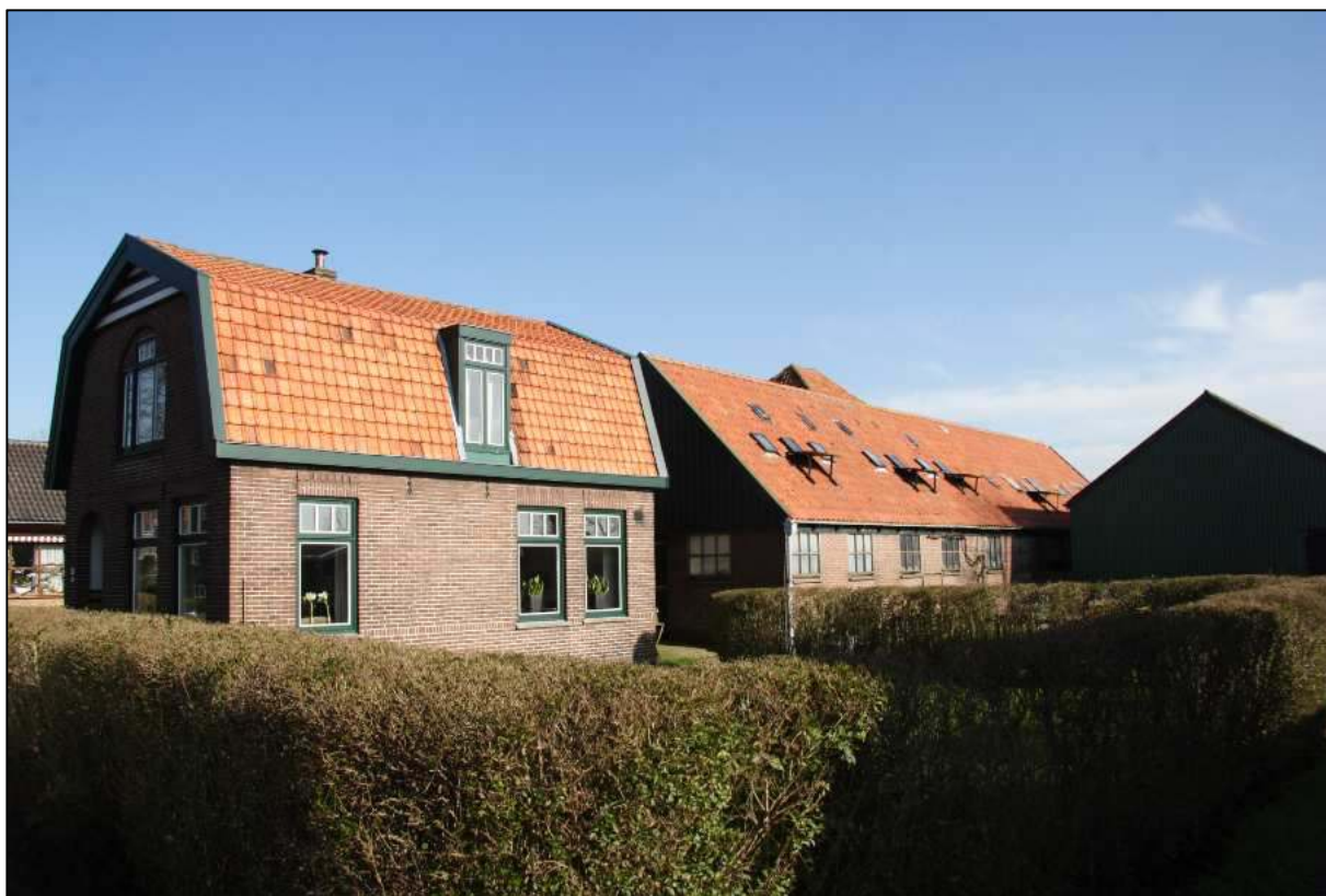
De boerderij J.J. Allanstraat 350 in 2013, met de stalling en hooiberg uit 1913 en het woonhuis uit 1926. De schuur rechts is in 2016 vervangen.
