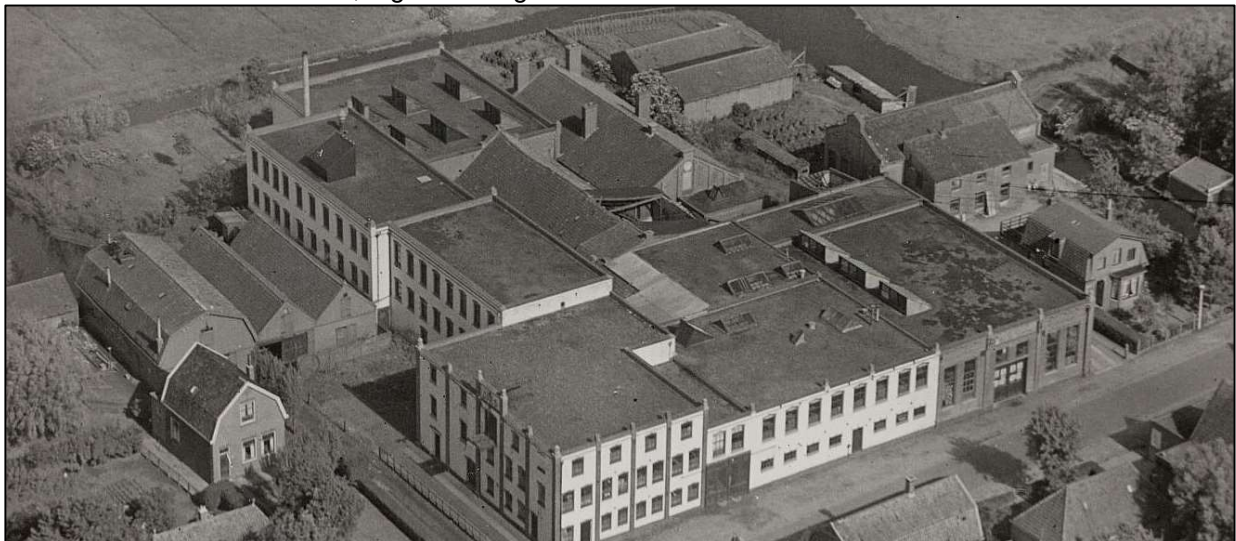
Luchtfoto van het bedrijf in 1951; links J.J. Allanstraat 306 (een vroeger kantoor van de fabriek, in 1931 verbouwd tot huis), vervolgens de fabriek en rechts J.J. Allanstraat 294-296, gebouwd in 1927. Daarachter het ketelhuis, gebouwd in 1926. Dit is als enige van het fabriekscomplex behouden gebleven. © Collectie GAZ, fotonummer 22.19001.
