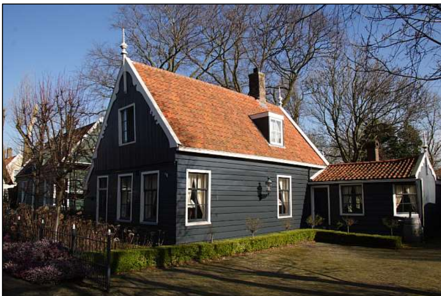
Onderste foto: J.J. Allanstraat 382 in 2014, tijdens restauratiewerkzaamheden.
