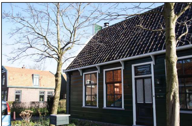
Het pand in 2014. Links nog juist zichtbaar de boerderij J.J. Allanstraat 350.
