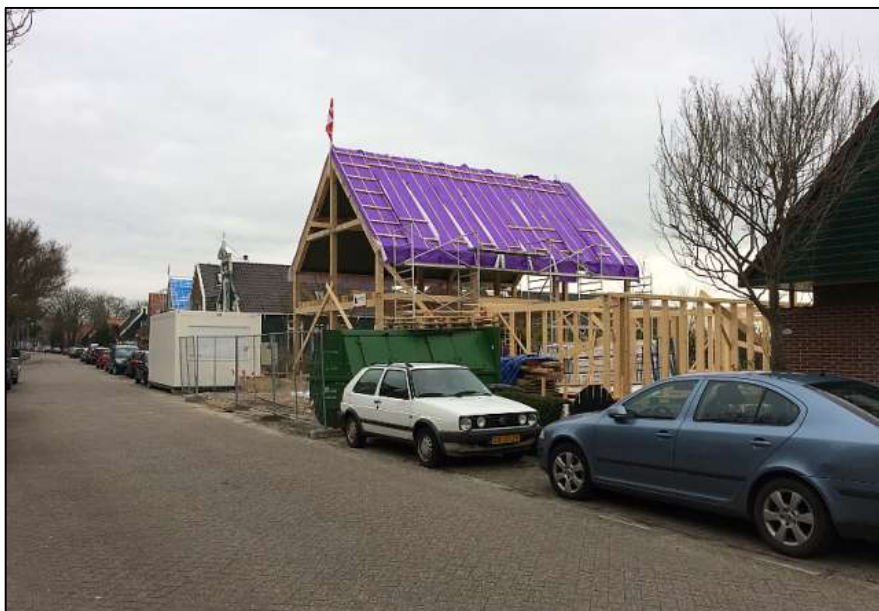
Het nieuwe huis J.J. Allanstraat 322 in aanbouw, maart 2017.
