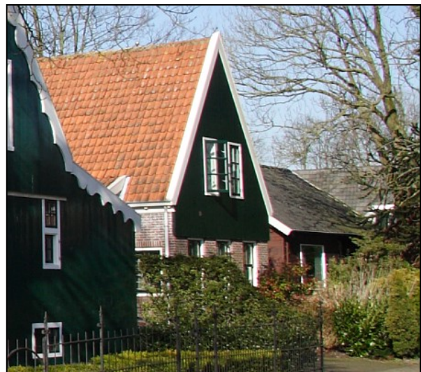
Rechts de in 1967 gebouwde woning J.J. Allanstraat 433 op de plek van twee 18 e - of wellicht zelfs 17 e -eeuwse panden.
