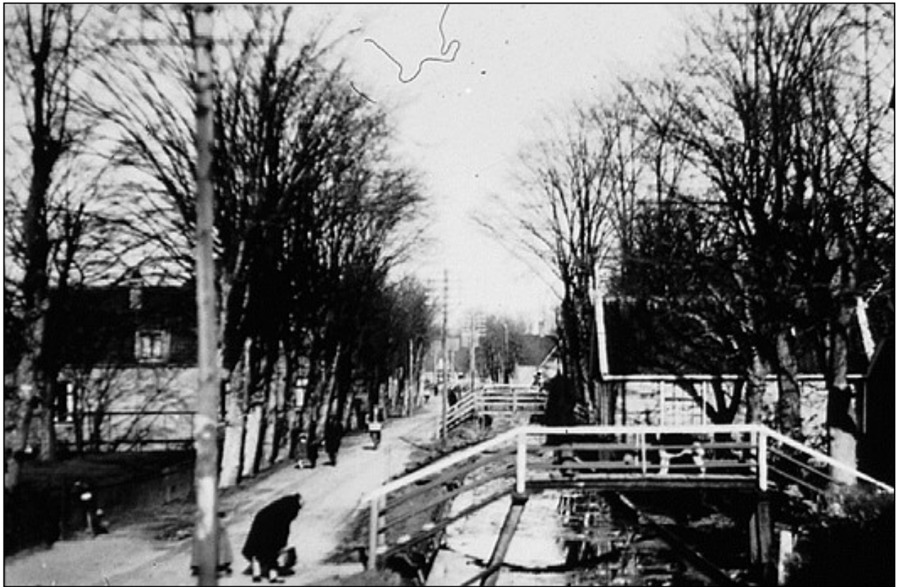
Het noordelijk deel van de J.J. Allanstraat, tot 1939 aangeduid als Krabbelbuurt. De foto is genomen eind jaren '20 vanaf de brug over de wegsloot naar J.J. Allanstraat 322. Uiterst rechts nummer 326-328 met (volgens gegevens van Nico Heermans) het fraaie voorschot van het woonhuis dat er tegenover gestaan heeft, op de plek van het vroegere "Bosje van Barthel". Op die plek staan iets verder inmiddels al wat huizen. In de verte is de brug over de Weelsloot te zien. Foto © Collectie Westzaanse Digitale Beeldbank/Nico Heermans.
