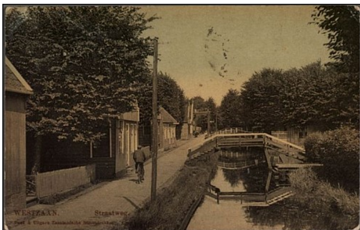
De J.J. Allanstraat begin 20 e eeuw, met van links naar rechts nummer 441, 447 (nog met de oorspronkelijke gevel voor 1940), 457 (in het verlengde van de telegraafmast) en nummer 459-461. Daarna volgt het hek van de Noordervermaning met vervolgens net voor de Weelbrug J.J. Allanstraat 465, 469 en 471. Foto © Collectie GAZ, fotonummer 41.01043.
