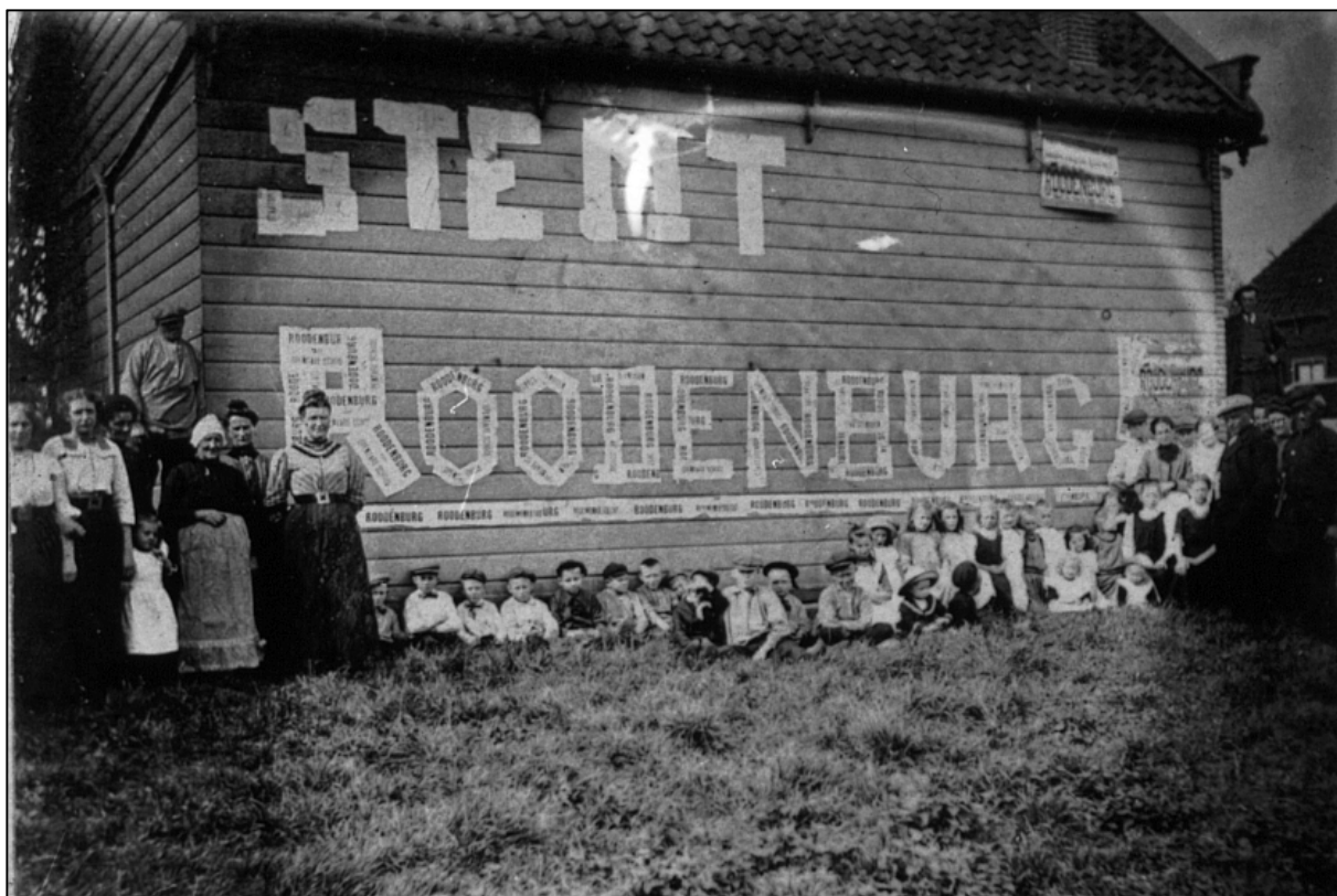
De zuidkant van het gymnastieklokaal begin 20 e eeuw. © Collectie Westzaanse Digitale Beeldbank/Nico Heermans.
