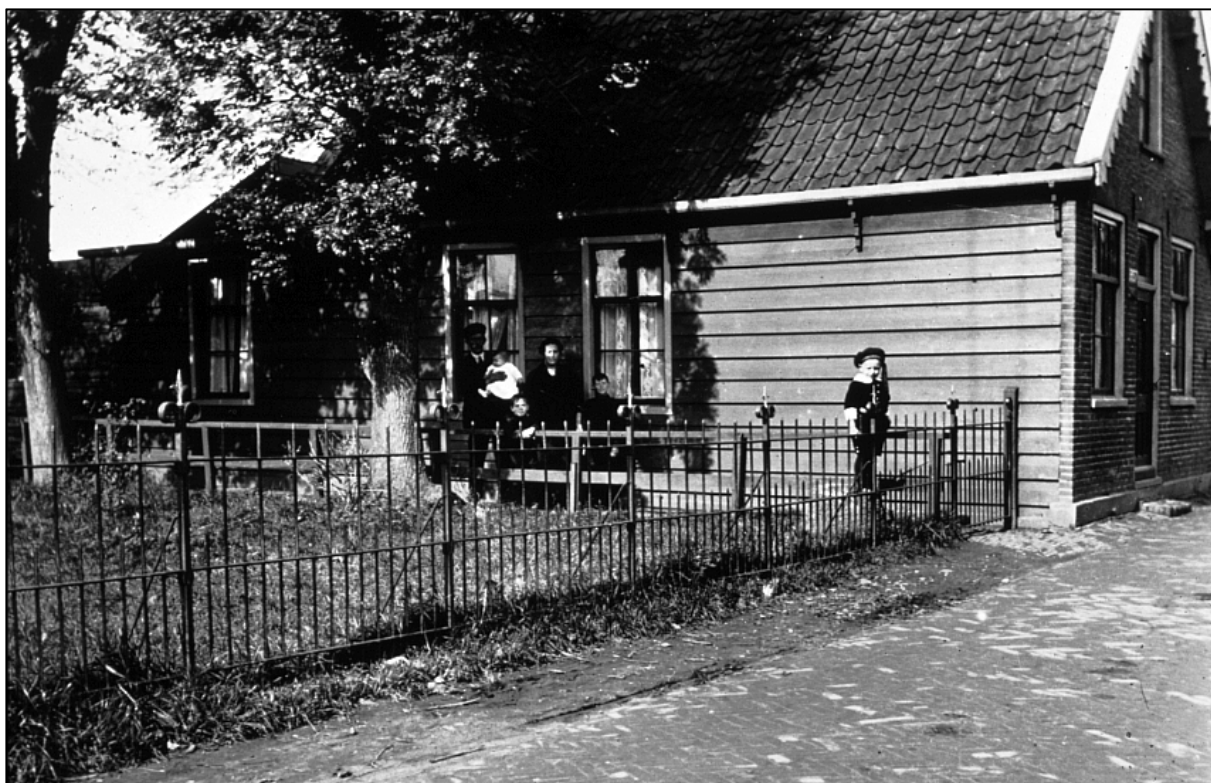
Zuideinde 239, gezien vanuit het zuiden. © Collectie Westzaanse Digitale Beeldbank/Nico Heermans.
