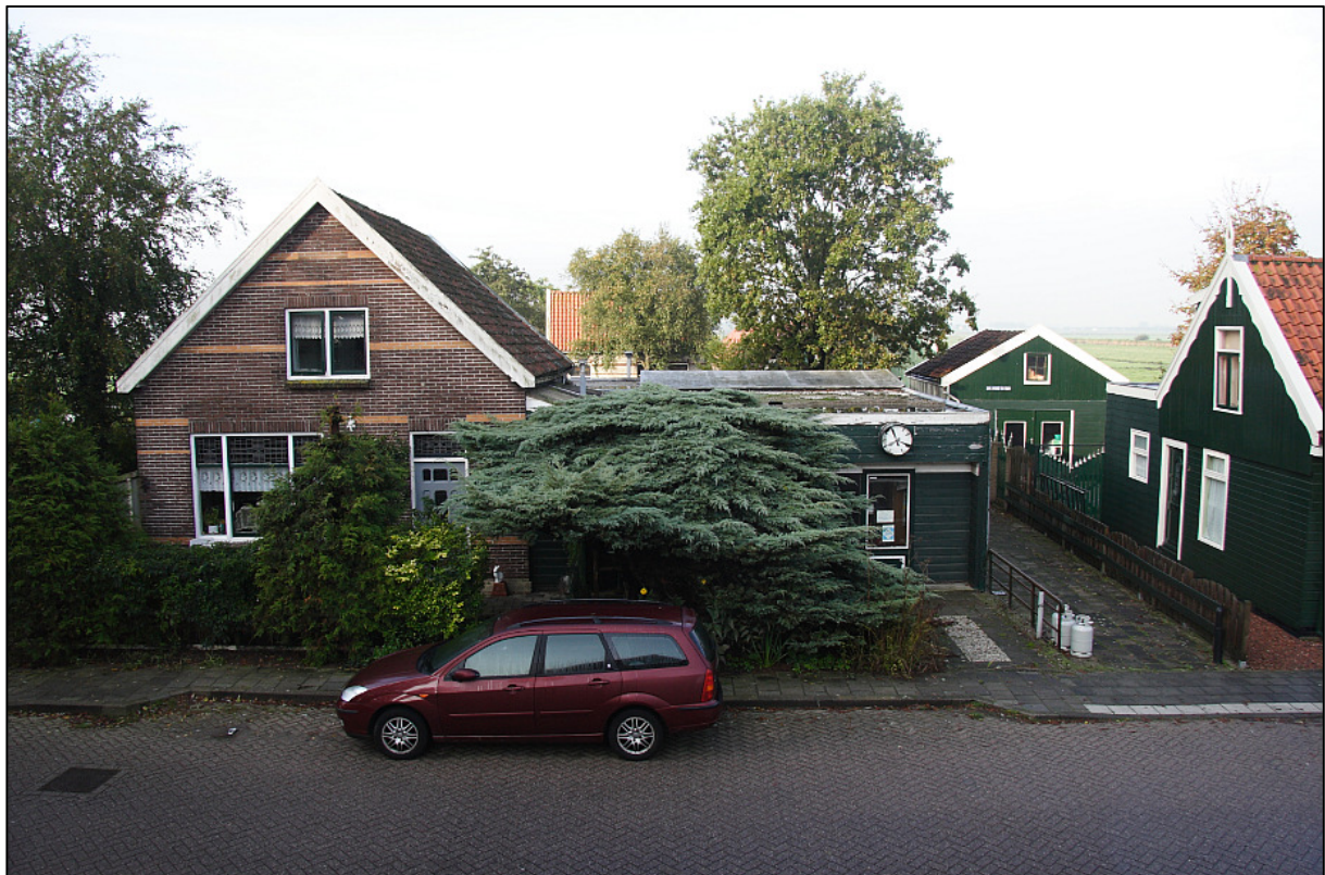
Zuideinde 253 met aanbouw uit 1968-1970 in oktober 2013, gezien vanaf de bovenverdieping van Zuideinde 256. Op de achtergrond het woonhuis van de boerderij Zuideinde 255, rechts het 19 e -eeuwse pand Zuideinde 257-259. © J.C. van der Male.
