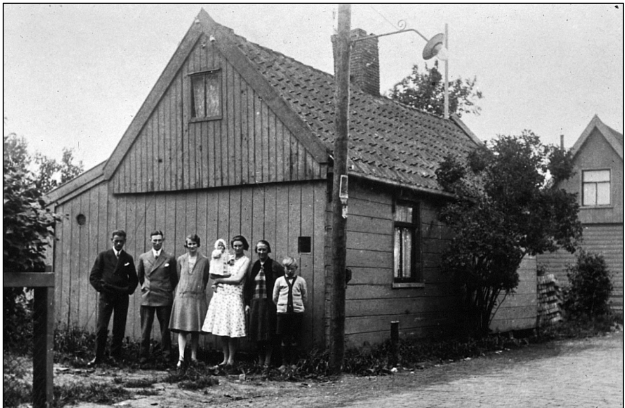
Het in 1864 gebouwde Zuideinde 257-259, voor de verbouwing in 1926 tot winkel. Rechts is het even oude pand Zuideinde 261-263 zichtbaar, voor dit in 1930 is vervangen door het huidige dubbele woonhuis. © Collectie Westzaanse Digitale Beeldbank/Nico Heermans.
