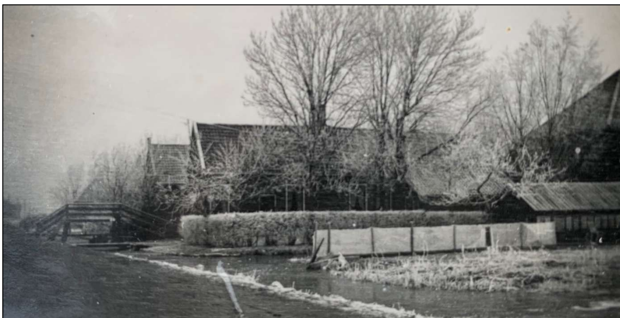
Links de oorspronkelijke voorgevel van de smederij Zuideinde 242. Rechts daarvan de boerderij Zuideinde 238-240. © Collectie D. Sman.
