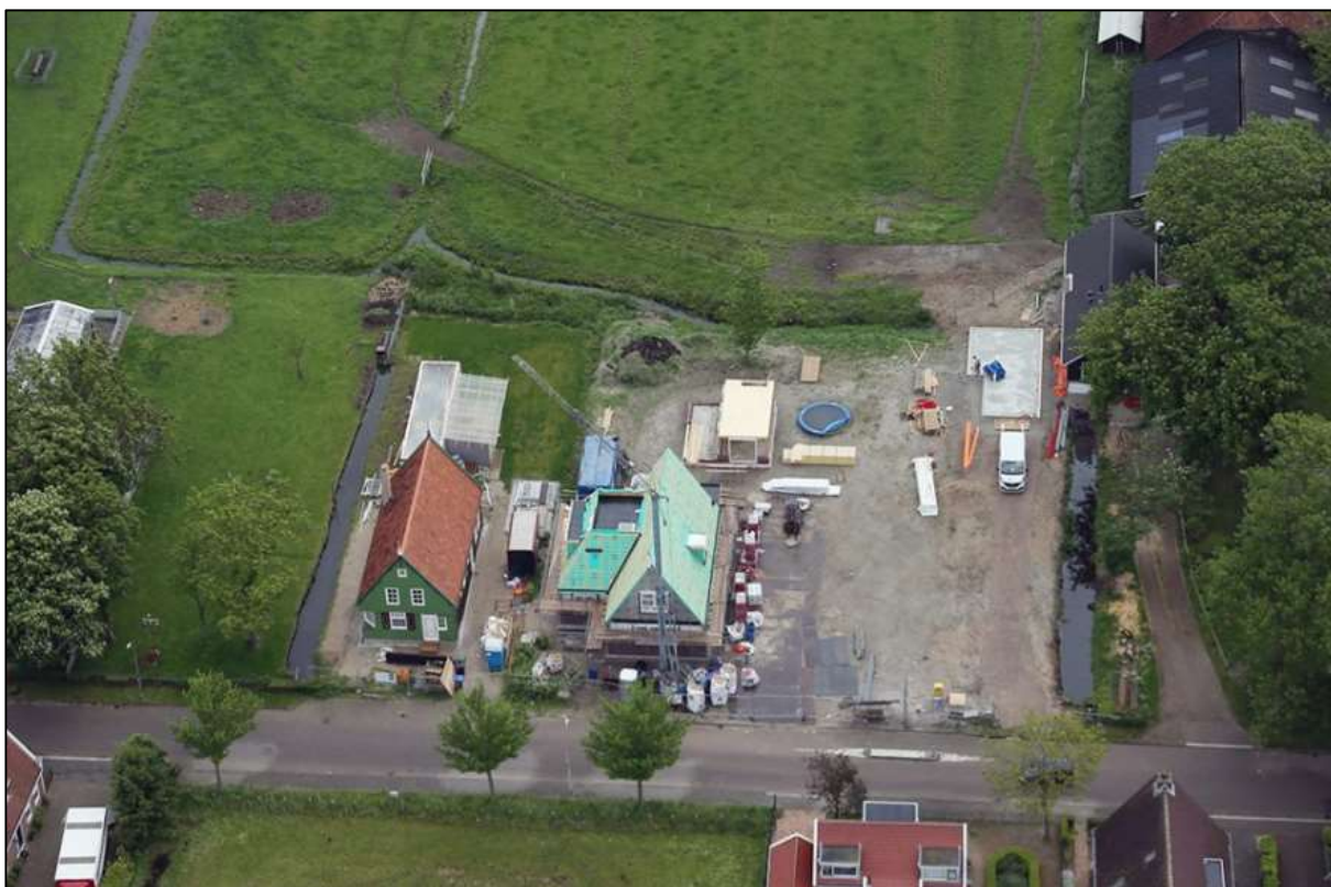
Luchtfoto van mei 2017 met v.l.n.r. de bouw van Zuideinde 224 en 222. Van Zuideinde 220 is de schuur in aanbouw. © Collectie Westzaanse Digitale Beeldbank/René Bloemberg.
