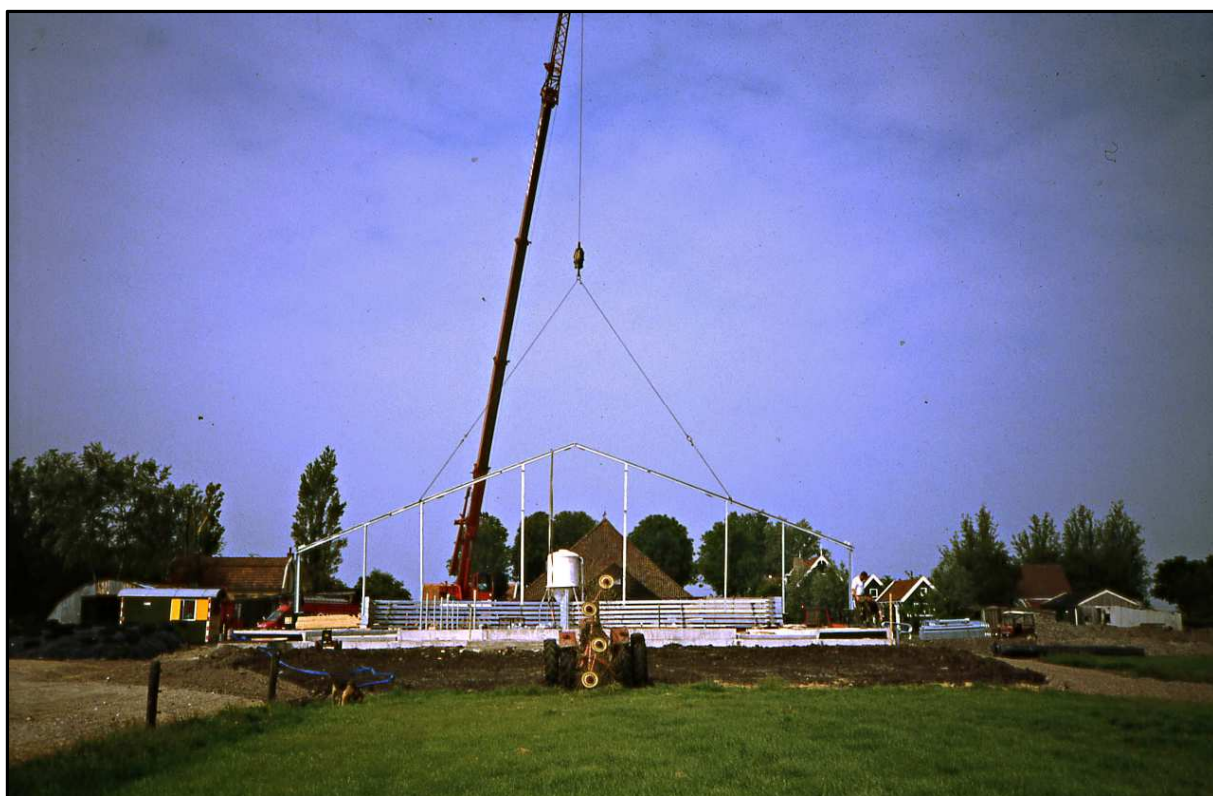
De bouw van de loopstal achter Zuideinde 260 in 1998. © Collectie A. Bax.
