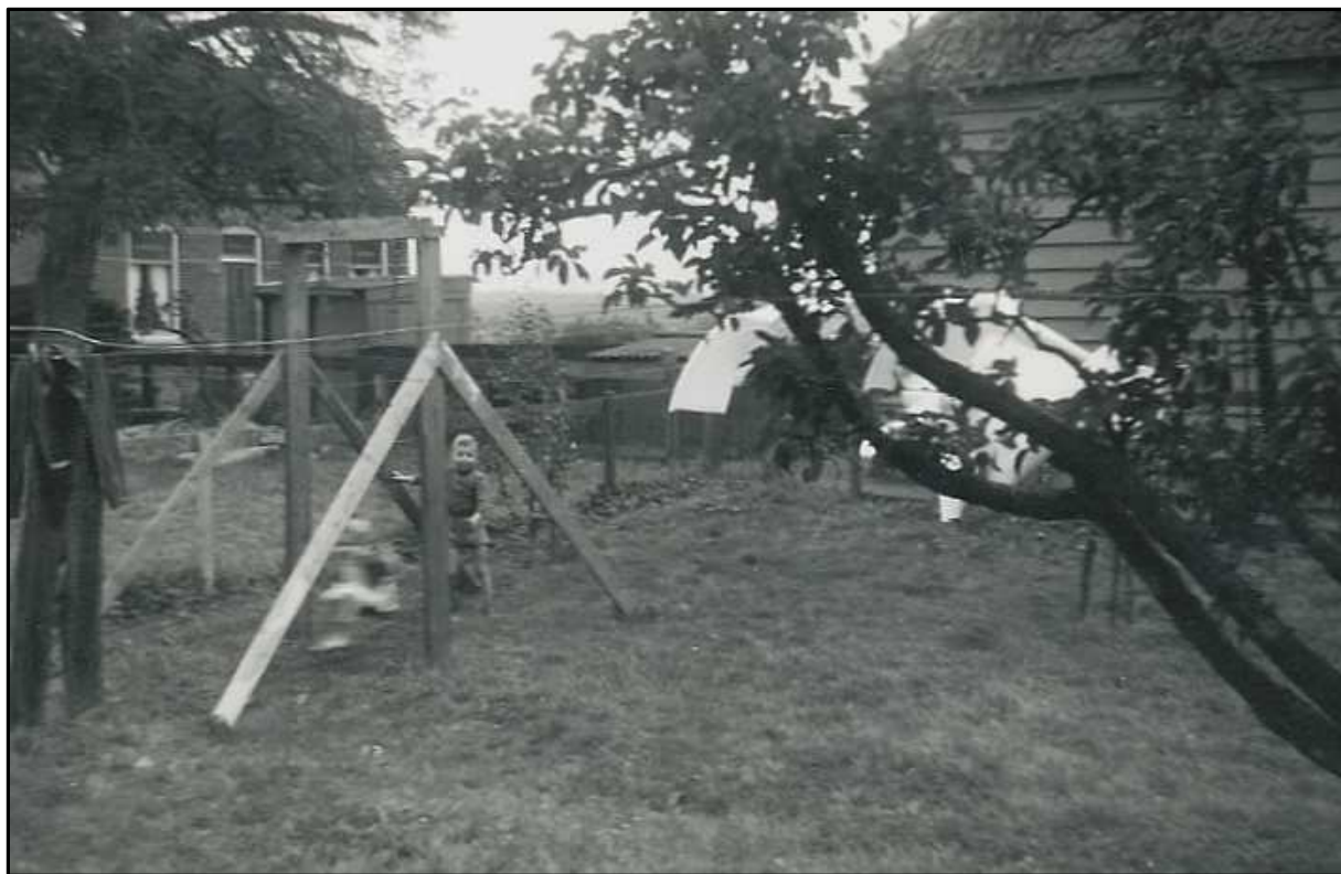
Zuideinde 258, gezien vanuit de tuin naast de boerderij. Rechts het achterste deel van het buurhuis Zuideinde 252-254, omstreeks 1960. © A. Bax.
