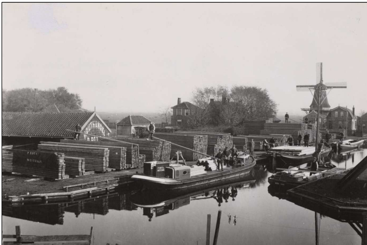
Zicht op het Zuideinde vanaf de Nauernaschedijk omstreeks 1920. Op de voorgrond het terrein van houthandel Rot. In het midden de achterkant van Zuideinde 81. Duidelijk zichtbaar de houten schuur achter de woning die van voor 1827 dateert en het luchthuis, dat als tweedehands in 1830 werd geplaatst. Op de achtergrond molen het Klaverblad met Zuideinde 94, gebouwd in 1912. De woningen Zuideinde 102-116 (gebouwd in 1926-1927) staan er nog niet. Collectie Gemeentearchief Zaanstad, fotonummer 22.01065.
