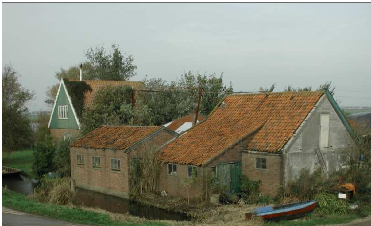
Links de in 1979 gebouwde woning bij de boerderij aan de Overtoom 170. Rechts de schuur die oorspronkelijk uit 1873 dateert, waar links van de kapberg stond en rechts ervan het eerste woonhuis. © Collectie Westzaanse Digitale Beeldbank..
