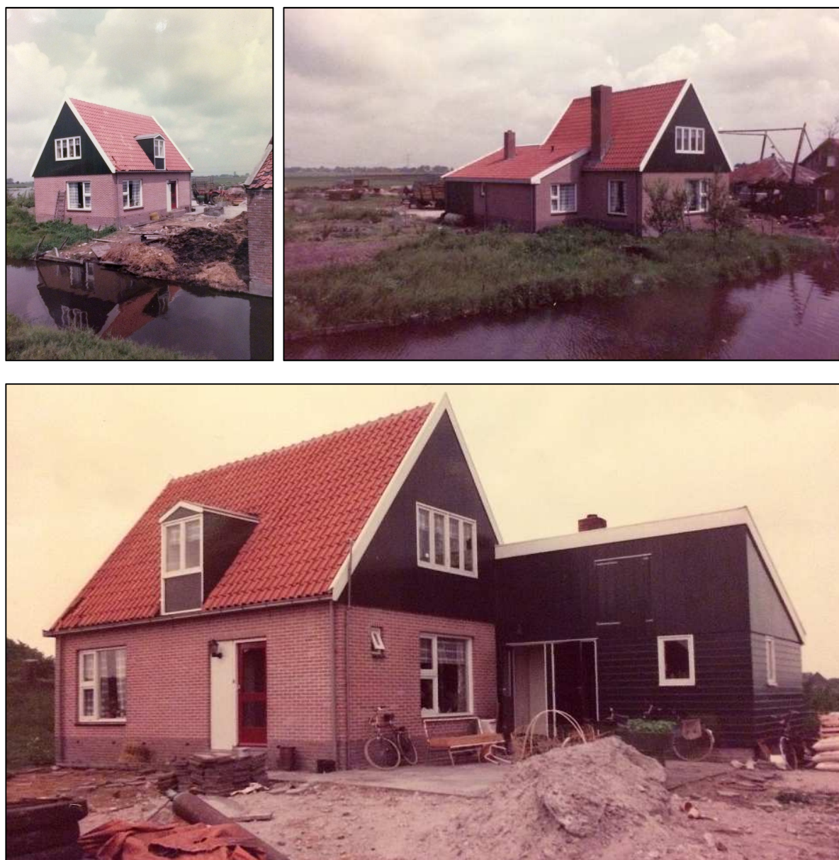
Het nieuwe woonhuis Overtoom 170 in aanbouw in 1979. © archief J. Schipper, Gemeentearchief Zaanstad
