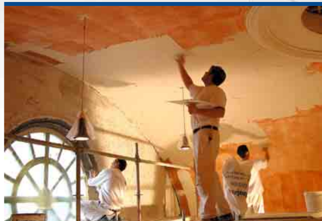
Stukadoors aan het werk.
